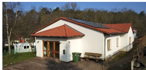
Abbildung 18: Mehrzweckgebäude Meimbressen (Quelle: Gemeinde Calden)
