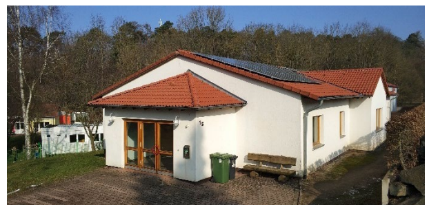
Abbildung 19: Mehrzweckgebäude Meimbressen (Quelle: Gemeinde Calden)
