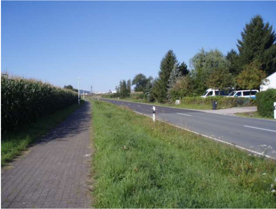
Abbildung 2: Geh-/Radweg mit Entwässerungsmulde im Norden
